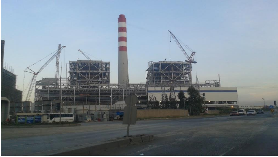
Şekil C.22 – Atlas Enerji Termik Santrali (Hatay ÇŞİM 2016)
